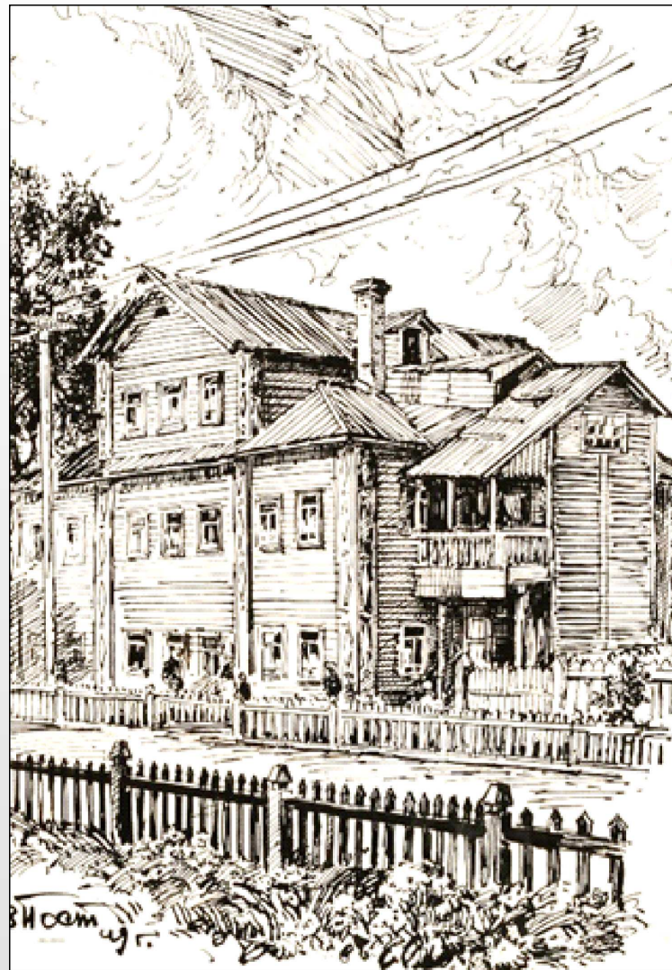
Постников В.Г. Дом в Сыктывкаре. 1949 г.
